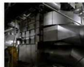
触媒検査装置
